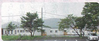
福島県福祉事業協会仮設施設（いわき市）
