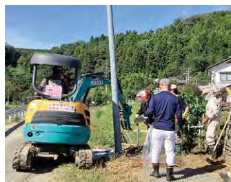
ショベルカーを使い泥の撤去作業を行う技術系ボランティア。
